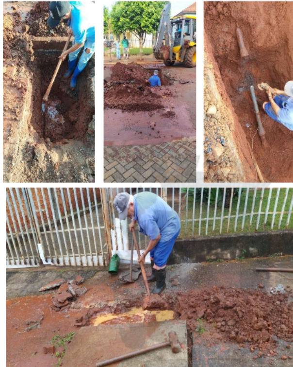
Foto: Manutenção da Rede de Distribuição Elaboração: Mundo Arquitetura
