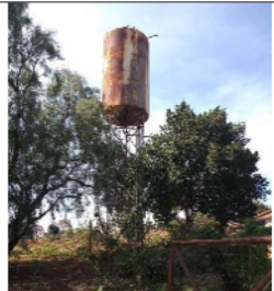
Reservatório Elevado Vila Flor do Vale
