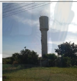
Reservatório Elevado Vila Adema, Pr
